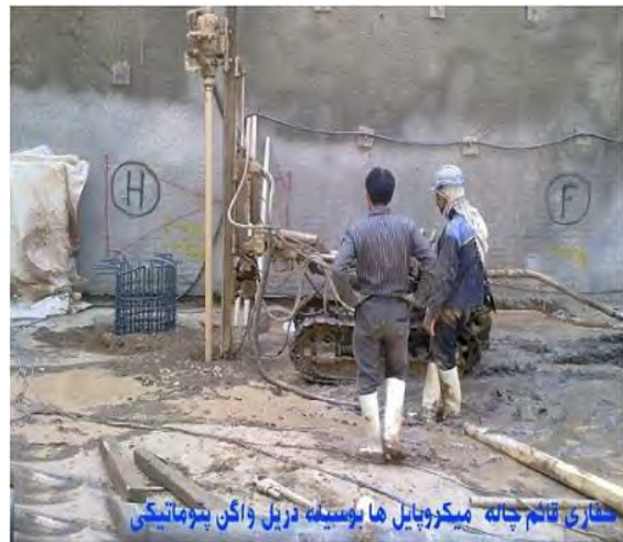
شکل ۷: حفاری قائم چاله میکروپایل‌ها بوسیله واگن
