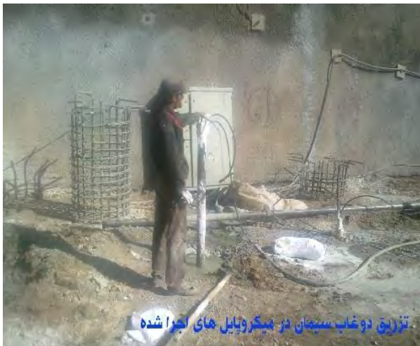
شکل ۸: تزریق دوغاب سیمان در میکروپایل‌ها
