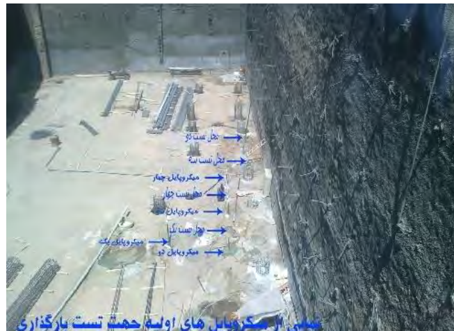
شکل ۶: نمایی از میکروپایل‌های اولیه جهت تست بارگذاری
